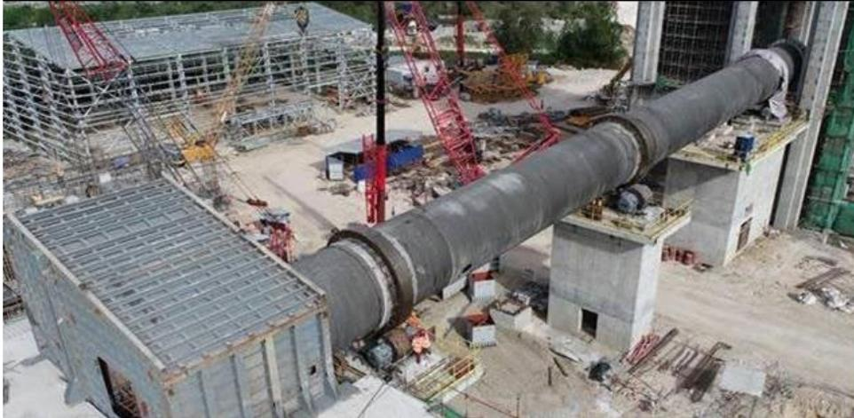
Levantamiento de nuevo horno giratorio en posición en planta de cemento Solid (Ene. 2021)
