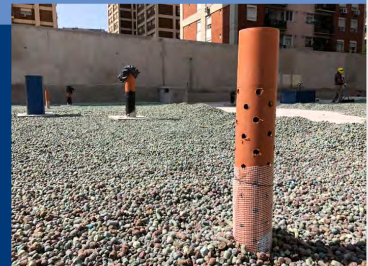
Arqlite SPC, una compañía estadounidense con sede en California, procesa los residuos de plásticos que no son susceptibles a ser reciclables para producir una grava artificial que se emplea como sustituto de los agregados naturales de cantera en la producción de un concreto ligero con baja huella de CO<sub>2</sub>, así como para instalar lechos de drenaje en la construcción y el paisajismo.
